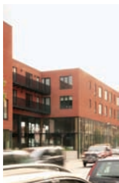
Centrale Werkplaatsen / blok E
